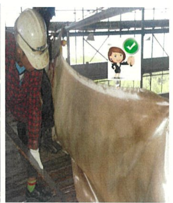
ไม่ทำการป้องกันลูกไฟทำให้ลูกไฟร่วงหล่นลงจากที่สูง
